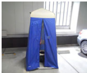
写真 5-6 マンホールトイレ (徳島中央署)
