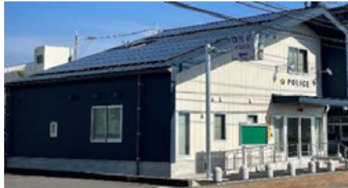
写真 5-11 県有施設初の ZEB 施設「藍住町交番」
