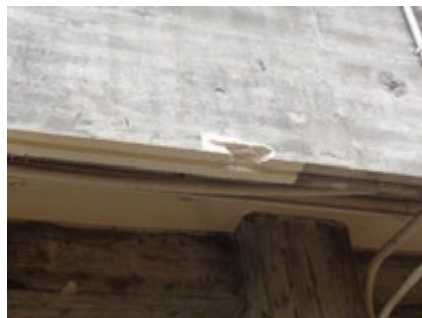
写真 2-3 外壁写真②
