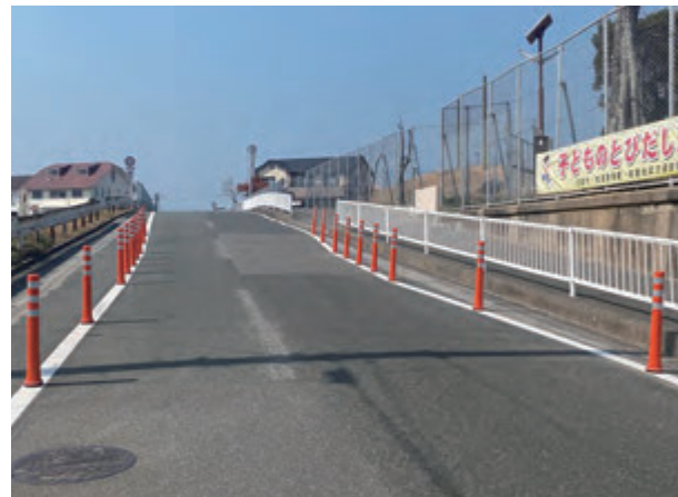
中央線の消去・狭さく設置状況 (福岡県古賀市)
