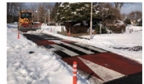
除雪作業の様子
