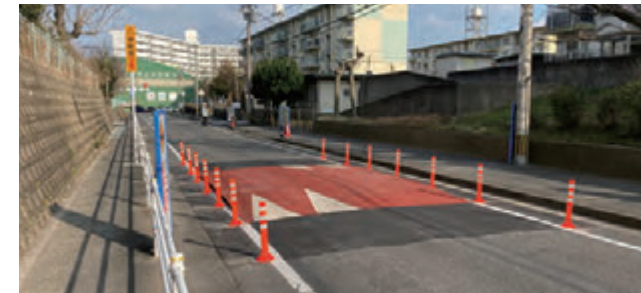
ハンプの試験設置の様子
