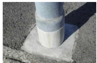
コンクリート処理
