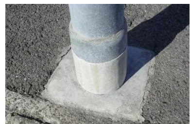
コンクリート処理
