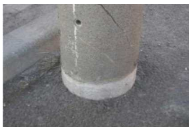
アスファルト処理
