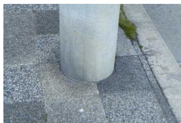
インターロッキング敷設
