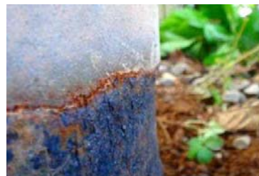
アスファルト部分を除去した状況（腐食が進んでいる）
