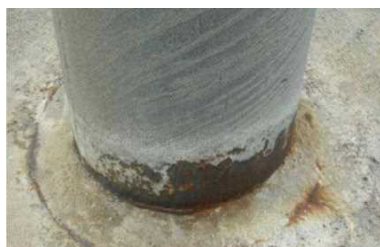
アスファルト部分を除去した状況（腐食が進んでいる）
